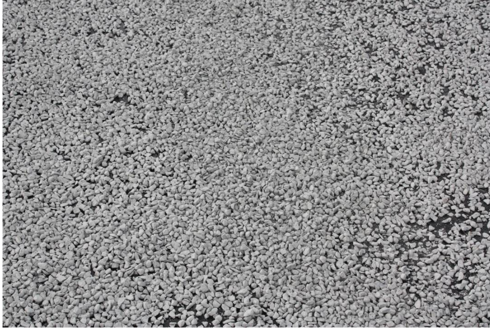
Figuur B6.6 Informatief: teveel afgestrooid membraan (volledig bedekt en deels zelfs dubbel)
